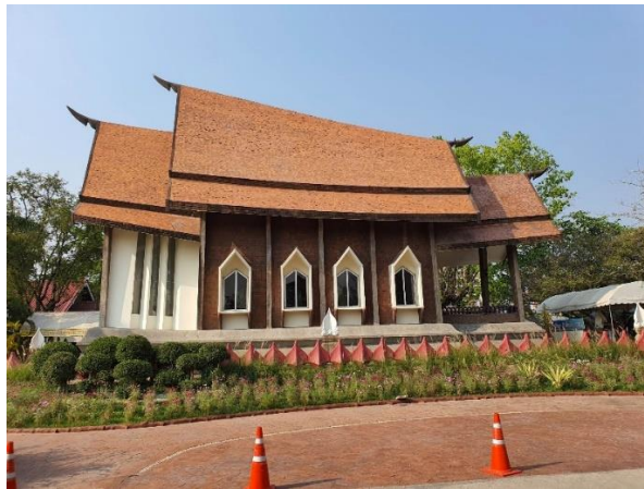
รูปที่ 4 รูปอาคารอุโบสถ วัดศาลาลอย ต้นแบบที่ได้เป็นแบบในการดำเนินโครงการฯ
